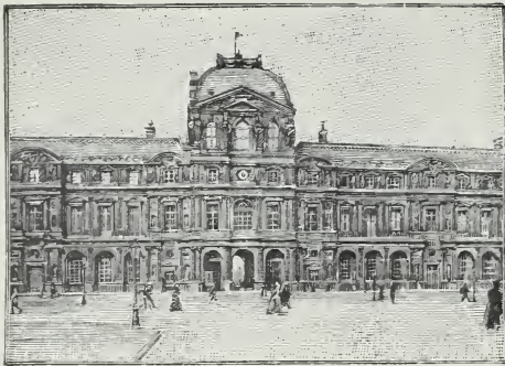
FIG. 207.—PATIO DEL LOUVRE (FACHADA OESTE).
